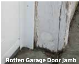
Rotten Garage Door Jamb
